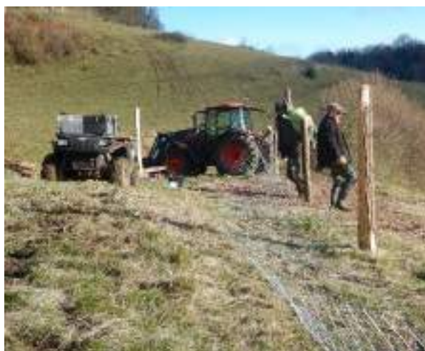
Travaux de clôture sur le site du coteau des Prés Saint-Denis © Vigot S
